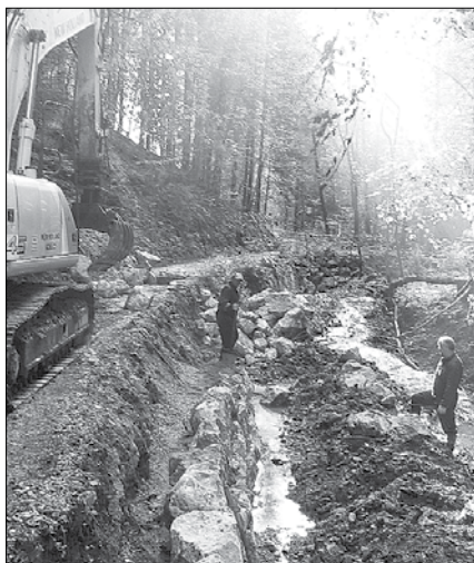
Dela na sanaciji ceste ob Mozirnici (Fotodokumentacija Občine Rečica ob Savinji)
