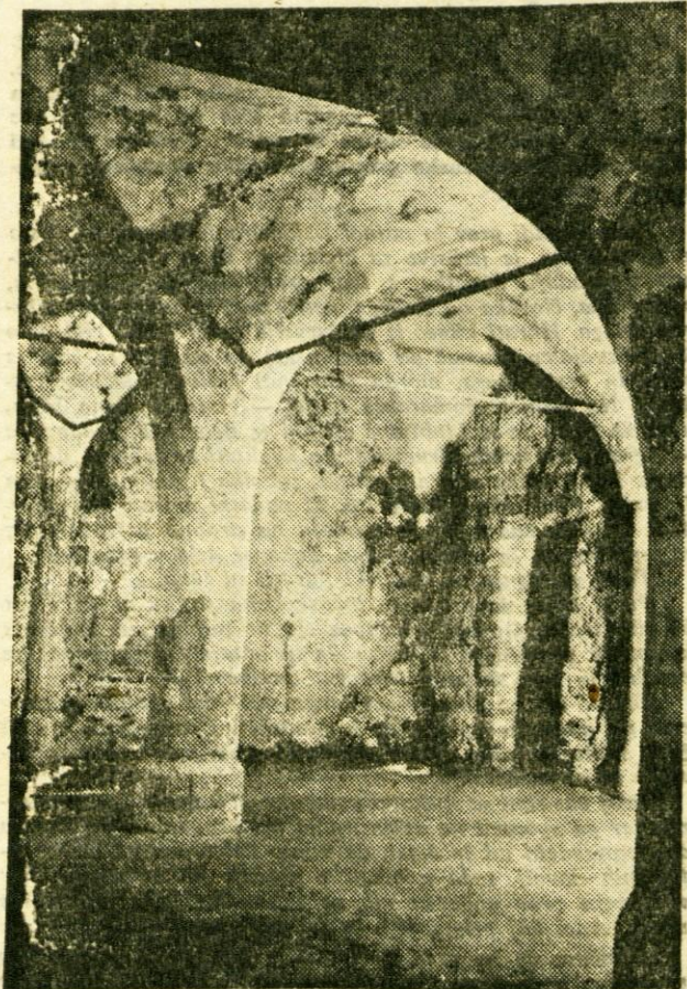
Mestna hiša v Kranju. Novo odkrita stenskična dvorana iz prve pol. 16. stoletja med restavriranjem
