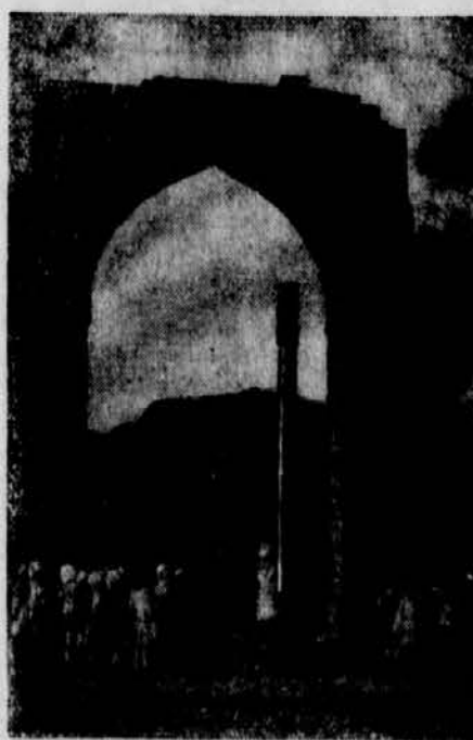
Die Kutub-Säule im Tempelhof zu Delhi. Geringfügig aus Schmiedeeisen von 40 cm Durchmesser, Höhe 7,25 m, Gewicht etwa 6.000 Kilogramm.
