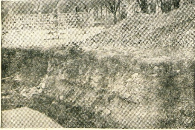
Gradbena jama za mrliško vežico pri žabniškem pokopališču, kjer so v profilu vidni temelji rimskega zidovja.
