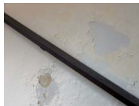
Slika 2 • Vlaga v zidovih in odpadanje ometa (levo in sredina) ter poškodbe na ometu zgradbe (desno)
