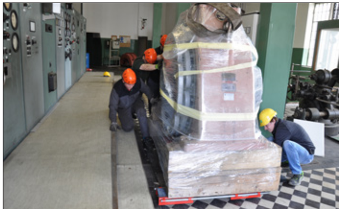
Elektrarna Vinka Majdiča, sedaj imenovana HE Sava, je bila pomemben proizvodni objekt za oskrbo z električno energijo kranjske industrije in inovacijski objekt tehničnih rešitev. Na sliki montaža obnovljenega agregata B v HE Sava, 16. april 2019. (Foto: D. Papler)
