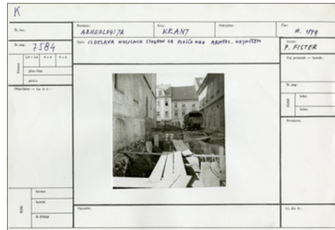
Gradbena dela za prezentacijo kostnice in krstilnice leta 1974, fotografija na kartonu (Avtor: P. Fister, arhiv ZVKDS, OE Kranj)
