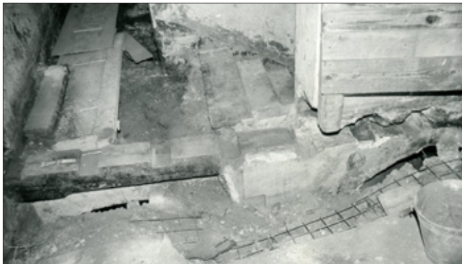
A/I/1, odkriti špirovci v tleh nad vhodno vežo (Arhiv ZVKDS OE Kranj)
