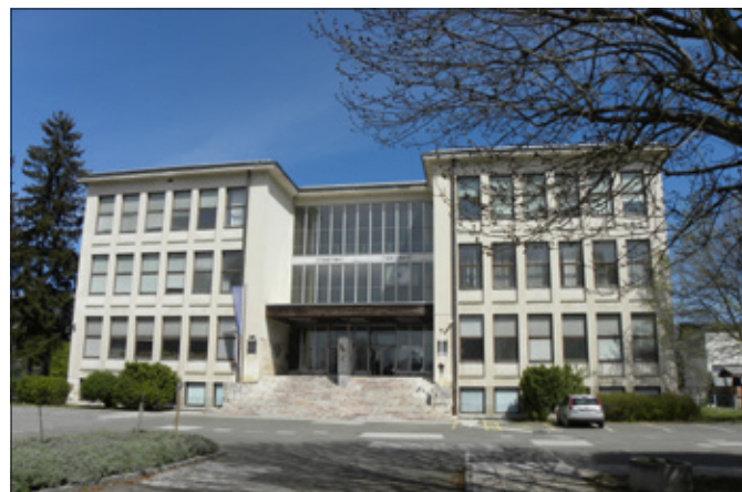
Tekstilna šola na Primskovem, v letih 1955–1958 zgrajena po načrtih arhitekta Emila Navinška. (Foto: Renata Pamič)
