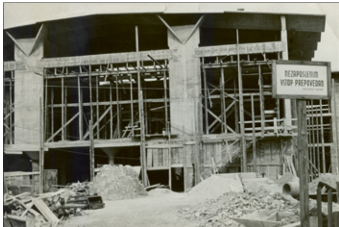
Plastično oblikovana konstrukcija v času gradnje (avtor fotografije neznan)
