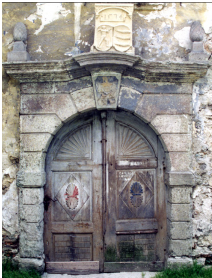
Vhodni portal z grbi, foto D. Tratar, hrani ZVKDS, OE Kranj.
