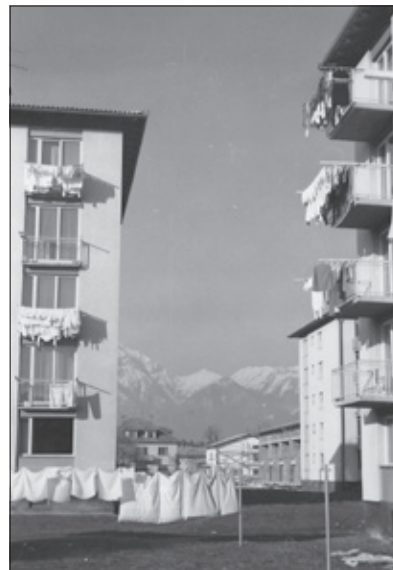
Nova stanovanja v naselju Vodovodni stolp sredi šestdesetih let. Med prosilci za družbena stanovanja so bile večinoma mlade družine. (Foto Tone Marčan, hrani Gorenjski muzej)
