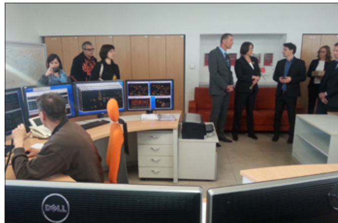
Distribucijski center vodenja Elektro Gorenjska je informacijsko vozlišče, ki upravlja, nadzoruje in vodi elektroenergetski sistem na Gorenjskem. Funkcije njegovega delovanja je ob odprtju, 16. maja 2016, vodja službe za obratovanje in vzdrževanje distribucijskega omrežja Elektro Gorenjska Gregor Štern (tretji z desne) pojasnil evropski komisarki za mobilnost in promet, mag. Violeti Bulc (četrti z desne), ob prisotnosti predsednika uprave Elektro Gorenjska, mag. Bojana Luskovca (peti z desne) in predstavnikom medijev; v ospredju sedi dispečer Matjaž Švab. (Foto: D. Papler)
