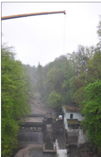
Spuščanje obnovljenega generatorja v hidroelektrarno Kokra, 24. april 2019. (Foto: D. Papler)
