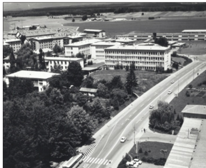
Nova porodnišnica, zdravstveni dom in zobna ambulanta na Zlatem polju. Zdravstvene ustanove in šole so bile na začetku šestdesetih let najbolj nujne gradnje v občini. (Foto Tone Marčan, hrani Gorenjski muzej)
