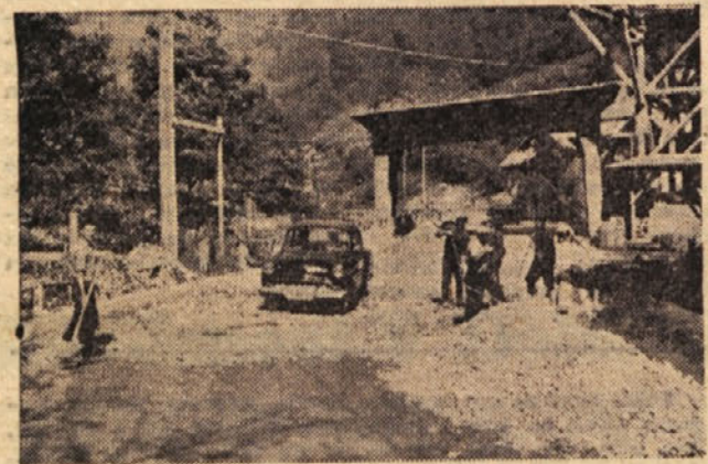
To soboto so začeli kockovati odsek ceste od laboratorija Cementarne proti železniški postaji
