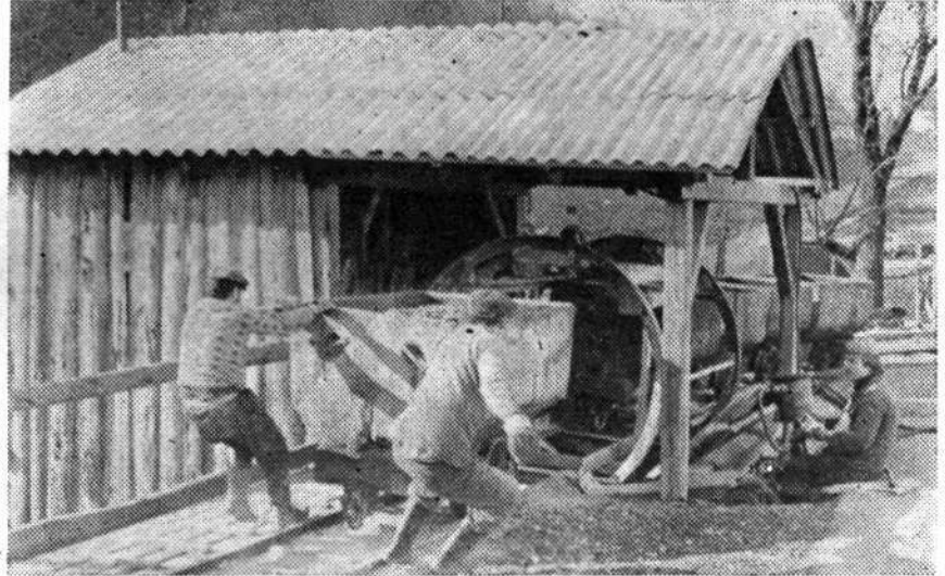
Naprava za pretovarjanje iz vagonetov na kamione v senovskem premogovniku
