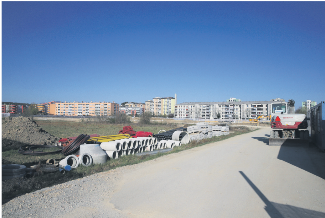
Gradbišče nove stanovanjske soseske DN 10
