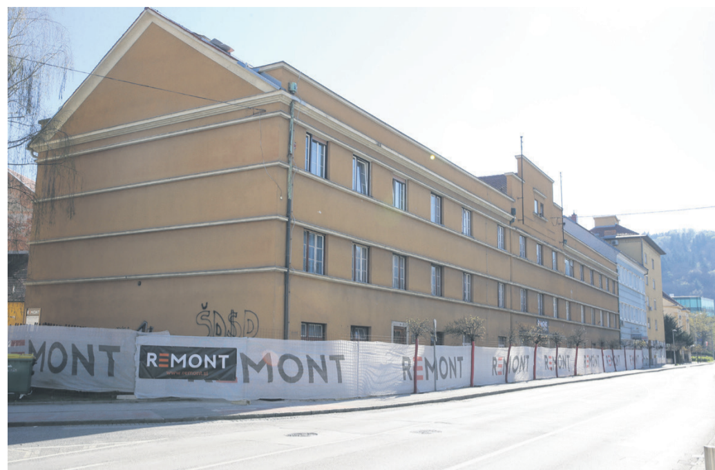
Pripravljala dela za gradnjo dodatnih prostorov zdravstvenega doma v Gregorčičevi ulici
