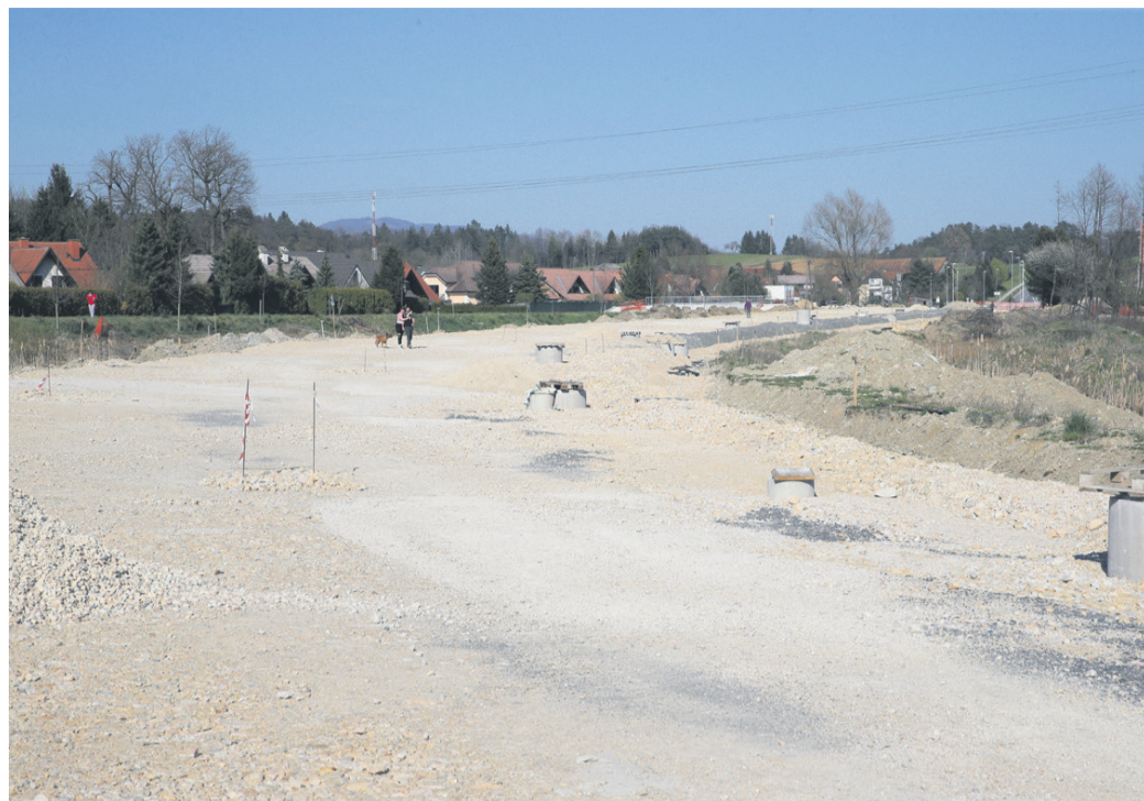
Gradbišče severne vezne ceste, ki bo predvidoma končana leta 2021, že kaže vidne orise končne podobe.
