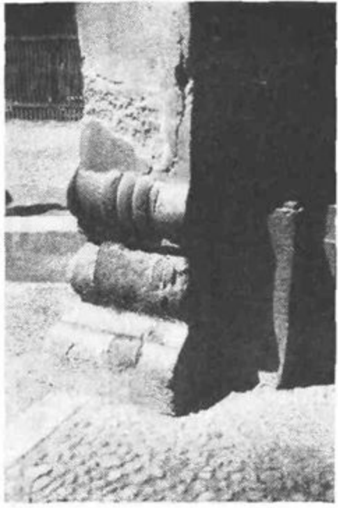
Sl. 3. Podstavki stebrov iz glinastega skrilmjavca v risalitu
