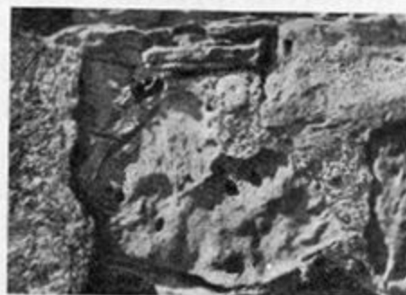
Sl. 1. Preperevajoči peščenjak in glinasti skriljavec v vzhodnem zidu gradu
