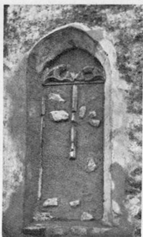
Sl. 1. Severno okno
