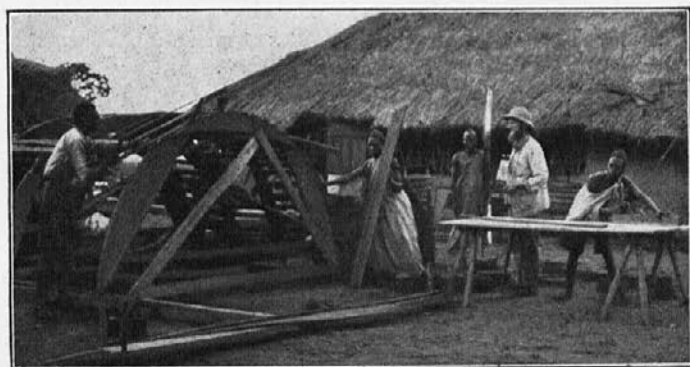
Brat Berhman postavlja streho za cerkev.
