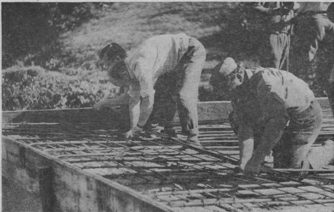
Za uverturo h gradnji plošče je bilo treba povezati železje.
