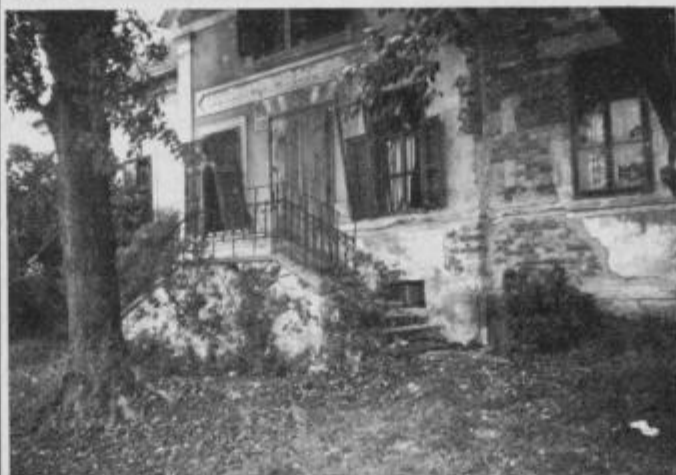
Pred obnovo je bila Polakova hiša v resnično slabem stanju.
