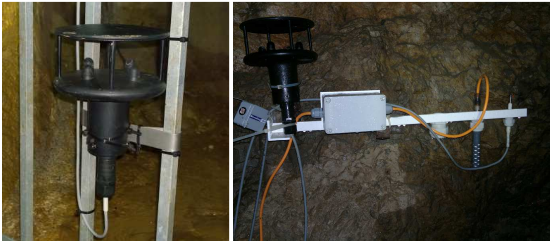
Slika 6: Slike montaže senzorjev na lokacijah »Pisani rov - vhod« (levo) in »Tartar« (desno«).
