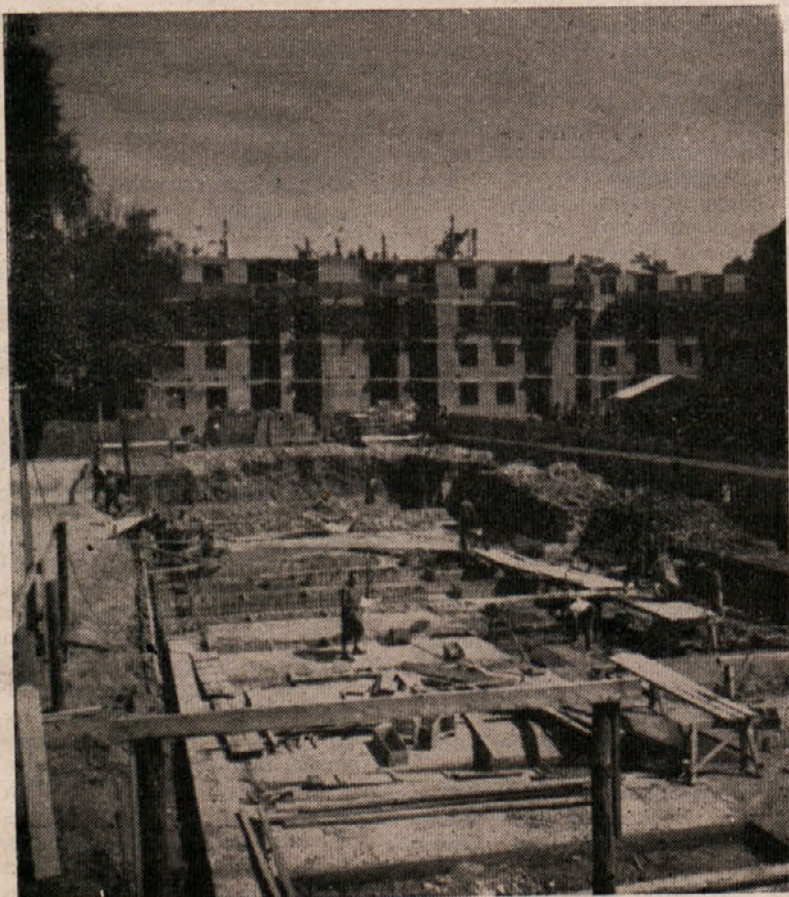
Gradbišče v II. fazi
