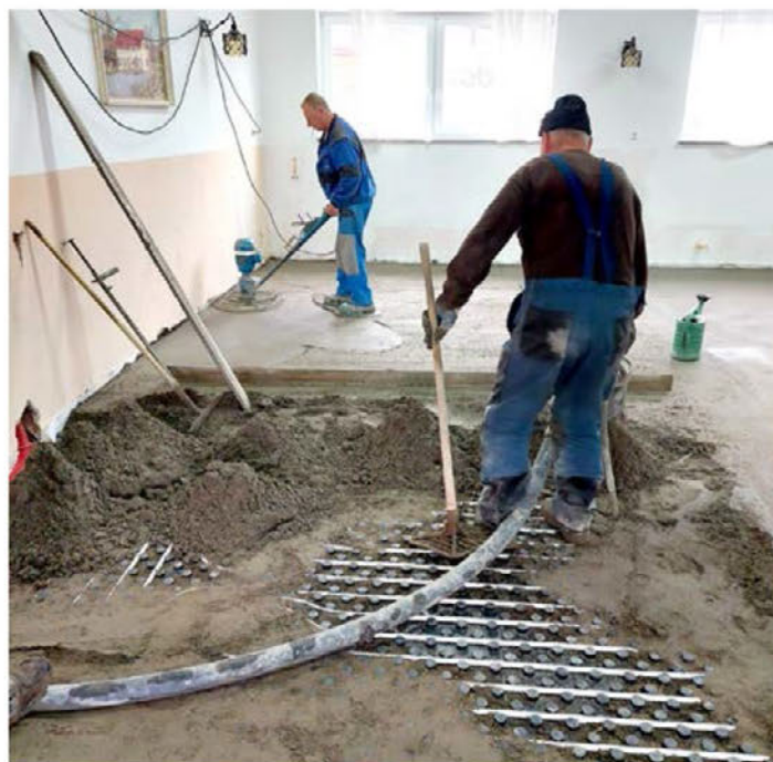
Dom krajanov Dolena se prenavlja. Na fotografiji mojstri izvajajo vgradnjo podtlakov.
