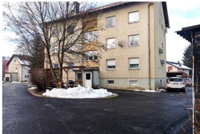
Okrog videmskega bloka je po novem asfalt. Foto: TM
