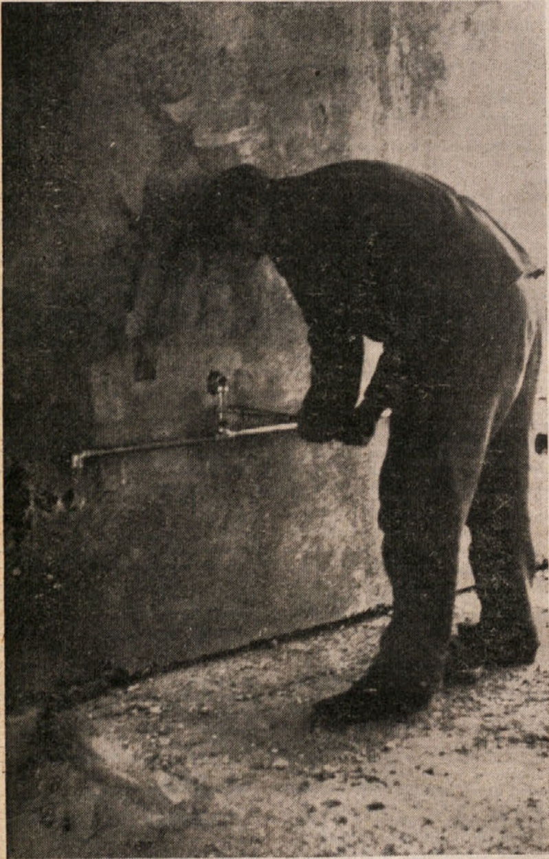
Dela v prvih 45. stanovanjih, zgrajenih po montažnem načinu, gredo h koncu. Tudi za inštalacije ni potrebno več »šteta«, tudi ta dela gredo po novem načinu mnogo hitreje od rok.
