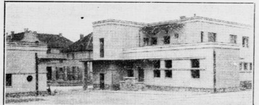
Vhod v carinarno z Vilharjeve ceste. Na levi hiša vratarja, na desni upravno poslopje
