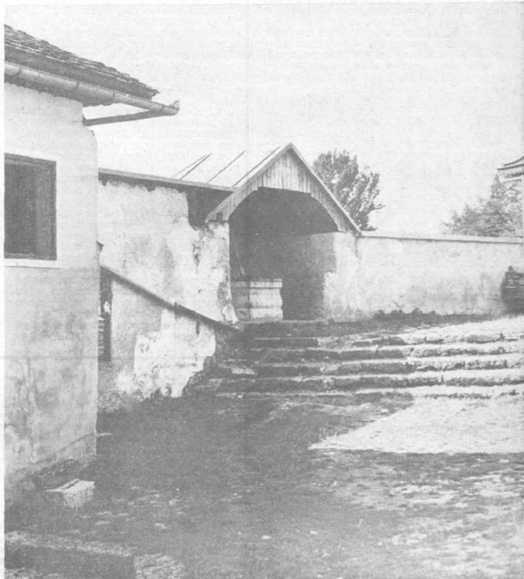
Obzidje nekdanjega obrambnega tabora proti Turkom obnavljajo. Na sliki: del zidu
