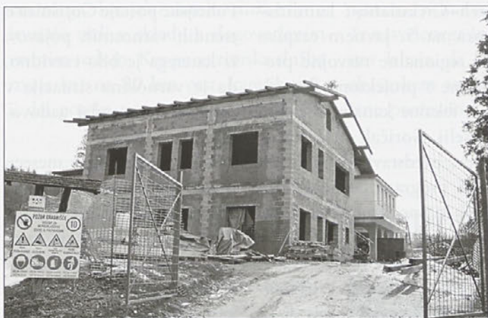
Gradnja občinske zgradbe poteka po terminskem planu.
