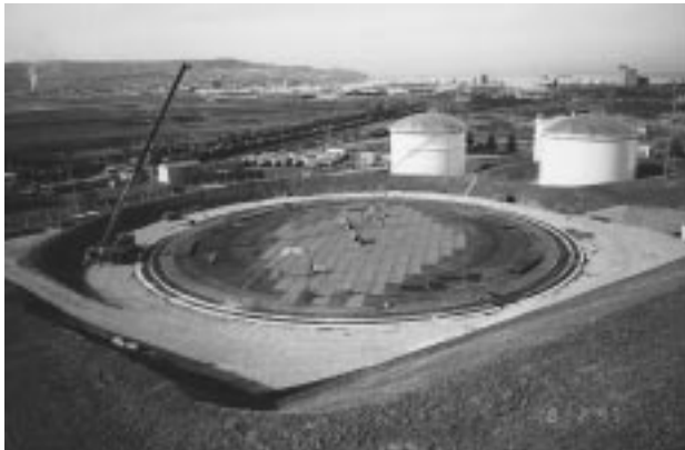
Slika 3: Varjenje dna rezervoarja Figure 3: Welding of tank bottom
