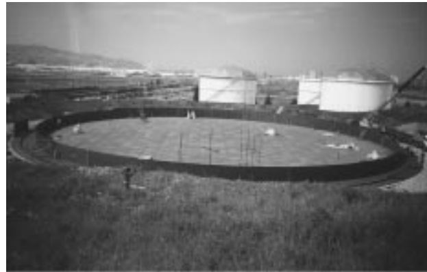
Slika 4: Gradnja plača rezervoarja Figure 4: The construction of tank shell
