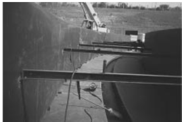
Slika 2: Podpiranje ploč- 1. venca rezervoarja Figure 2: Supporting of the first tank shell
