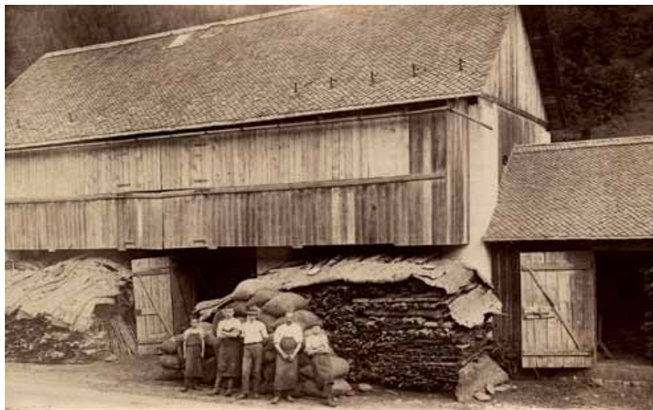
Terilnica lubja na Kovniku ob reki Sori, zgrajena okoli leta 1906. Pred leseno zgradbo je zloženo lubje, pripravljeno za obdelavo v terilnici. (v zasebni lasti)
