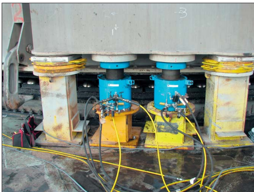
Slika 5. Ena od treh podpornih točk bagerja s parom hidravličnih dviznih valjev s posamično nosilnostjo 630 t
