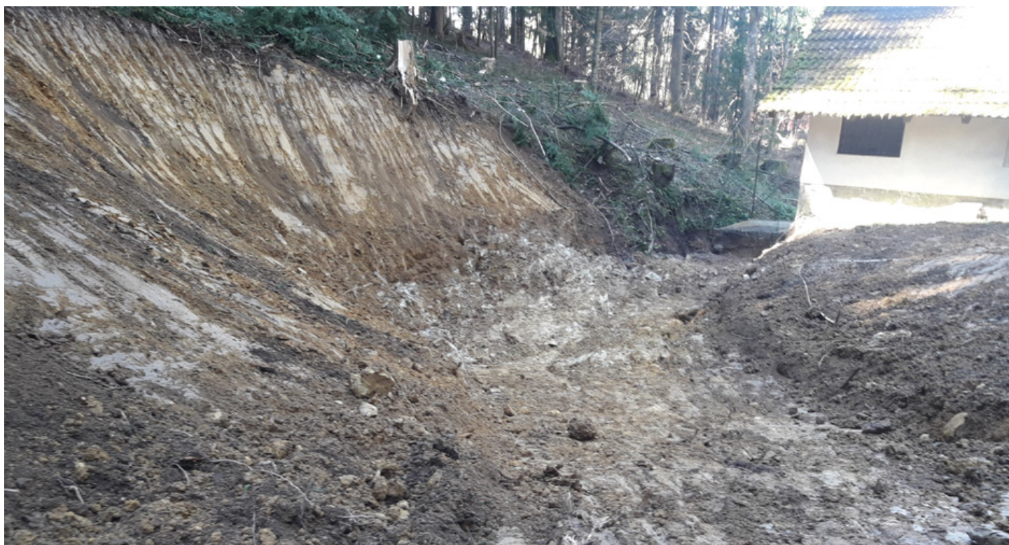
Črpališče Zajele – izkop
