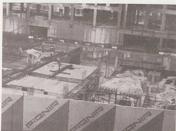
S tem posnetkom vidimo sistem fazne gradnje parkirne hiše, ki se z gradnjo približuje k B objektu.
