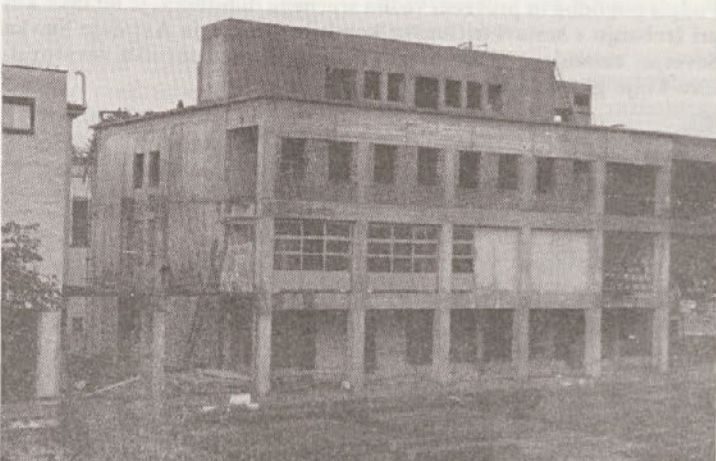
Povezava obstoječe in nove pošte je v dveh nivojih. Spodnji ostaja v prvotni funkciji prehoda ljudi proti križišču novega mostu. V ospredju vidimo pripravo armature pred betoniranjem druge plošče garažne hiše.
