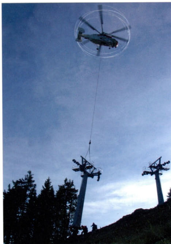
Helikopter je opravil levji delež pri montaži. (foto Hans Avberšek)
