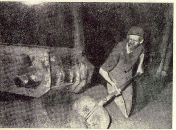
Transport premoga iz mehaniziranega širokega čela s transporterjem na zbirni trak
