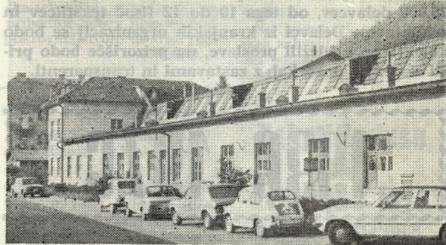
Upravna stavba v obratu I
