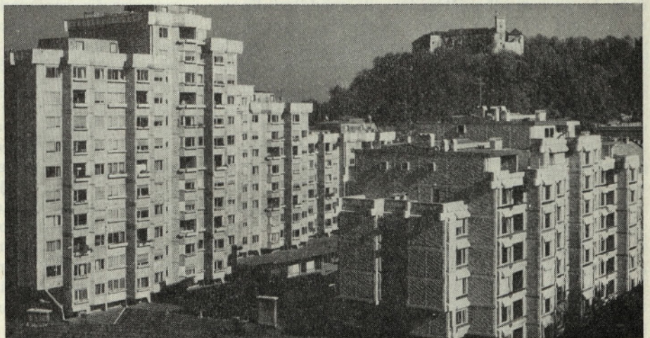
Del gradbenega kompleksa »Ferantov vrt« v Ljubljani (GP TEHNIKA)
