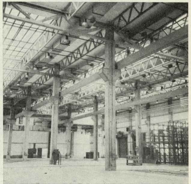
Montažna hala centralnih obratov ZŽTP (GIP GRADIS)
