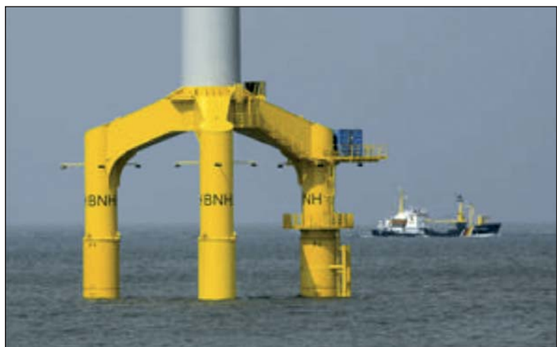
Edinstven koncept trostebrnega temeljenja – BARD Tripile
