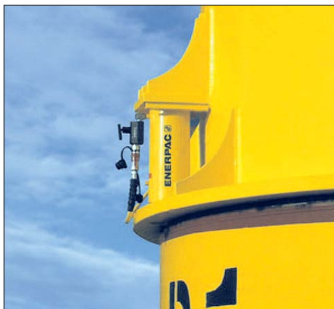
Pri montaži popornega križa so bili na vsak steber nameščeni trije valji zmogljivosti vsak po 100 ton, razporejeni po krogu
