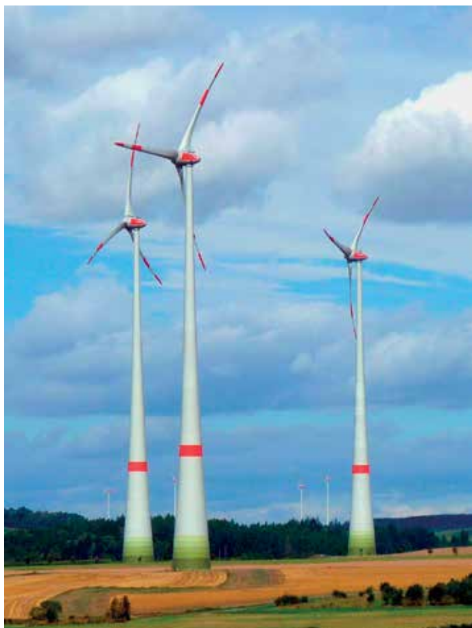
Sliki 2 in 3: Vetrna elektrarna pri Senožecah in polje vetrnih elektrarn v Nemčiji.
