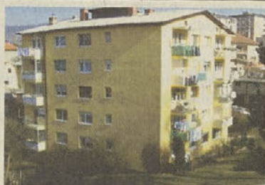
Eden prvih blokov v Zasavju, kjer so se lastniki odločili toplotno izolirati fasado
