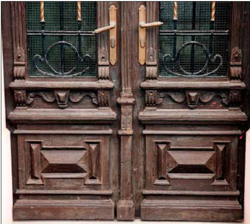
Detajl spodnjega dela vratnih kril Kemperlove hiše.
