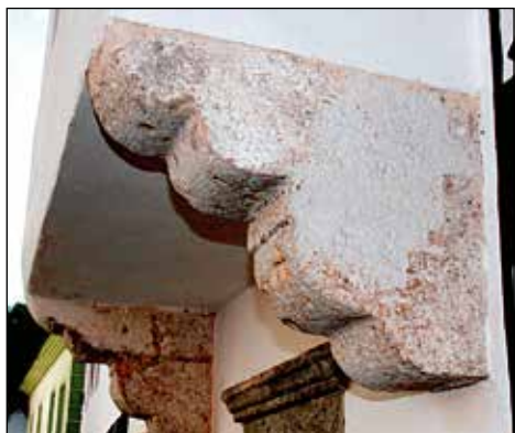
Detajl spodnjega dela prižnice.
