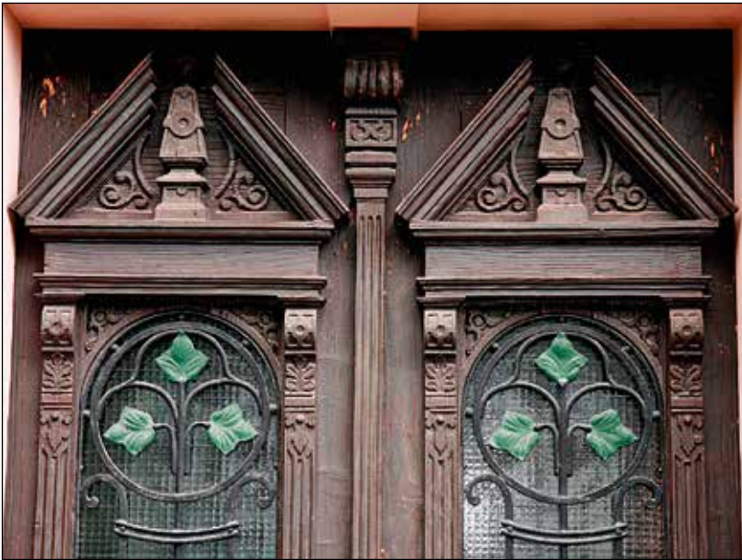
Detajl zgornjega dela vratnih kril Kemperlove hiše.
