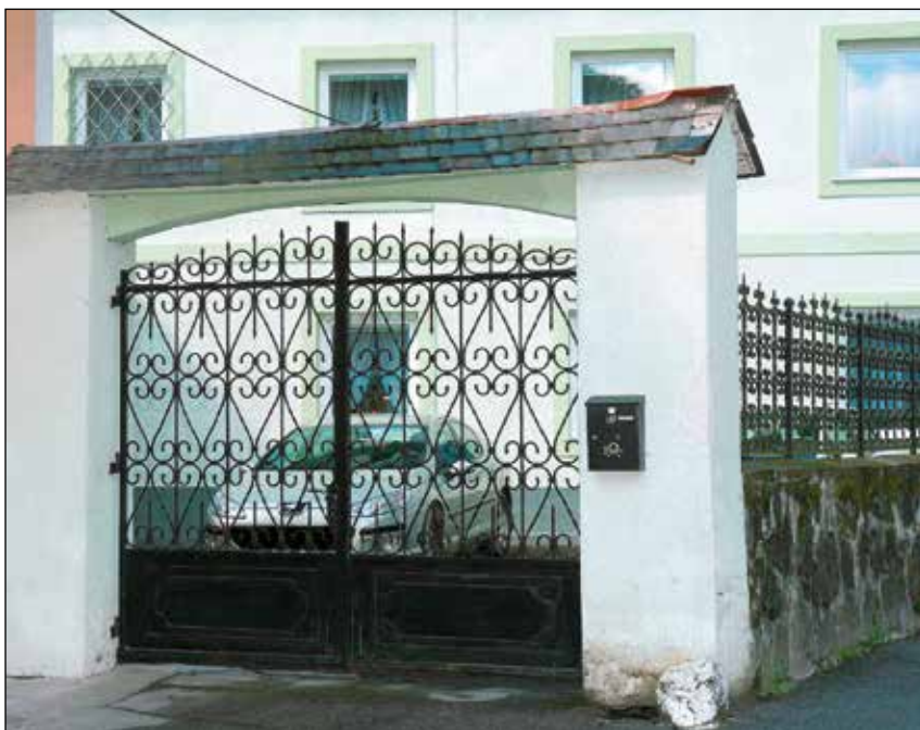
Vhod na dvorišče Hafnarjeve hiše, obok z zidanimi stebri in pokrit s skrilmom.
