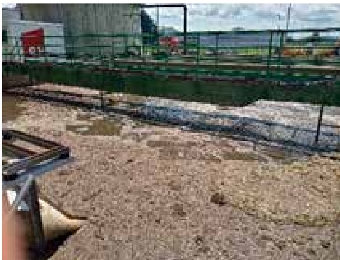
Obstoječi čistilni bazen, ki bo v kratkem rekonstruiran
