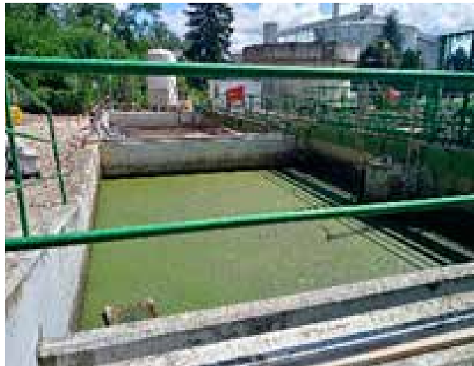
Obstoječi stari bazen, ki bo rekonstruiran
