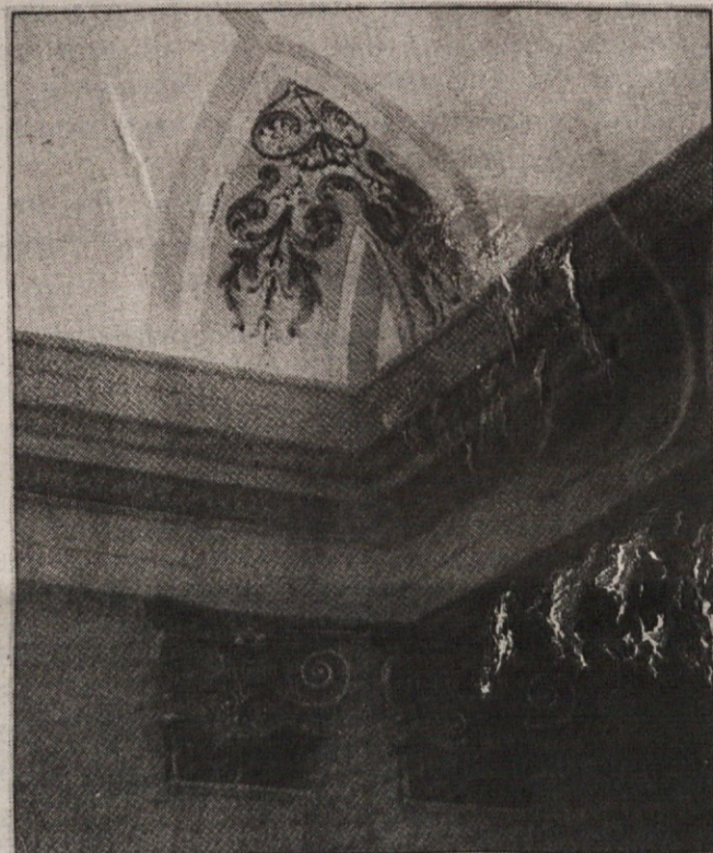
RESTAVRIRANE ŠTUKATURE – V pred- dverju in veliki dvorani so pri obnovi pod plastmi barve odkrili štukature, ki so jih bržčas prebarvali ob preurejanju stavbe leta 1936.
