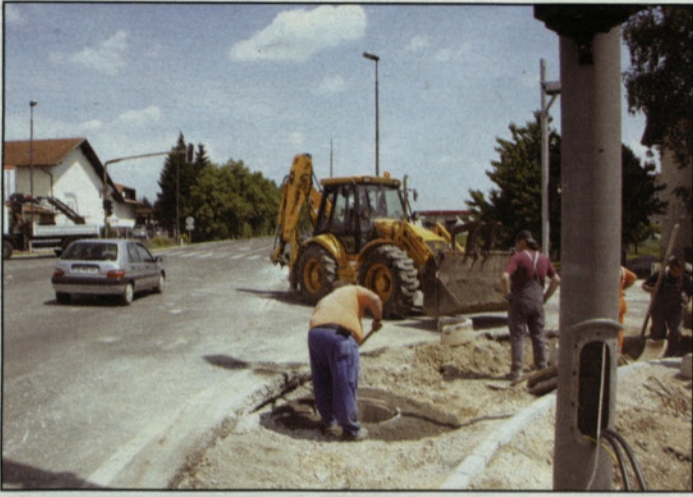
Rekonstrukcija Gotoveljske ceste in deloma tudi križišča z obvoznico
