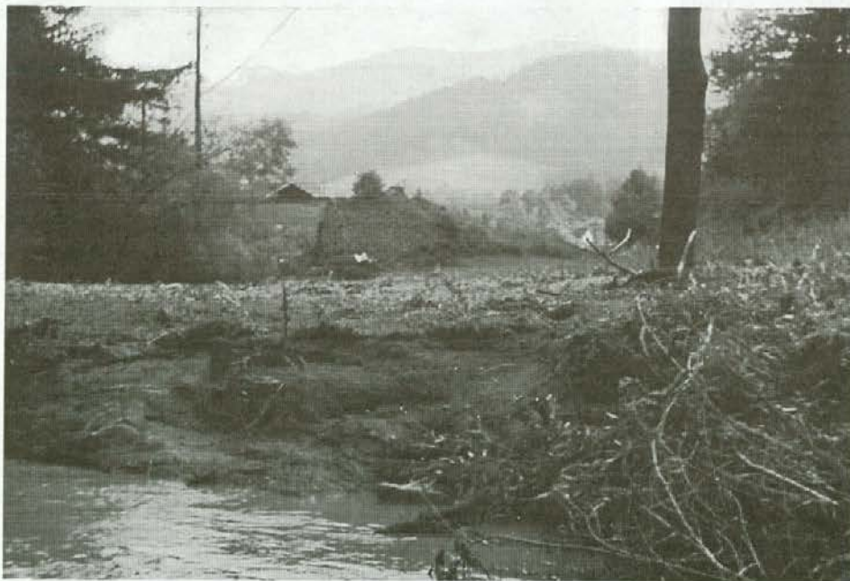
V Završah je potok Mevlja v nižinskem delu v Mrakovem jarku praplavlil cesto, njive in travnike in poškodoval leseni most.
