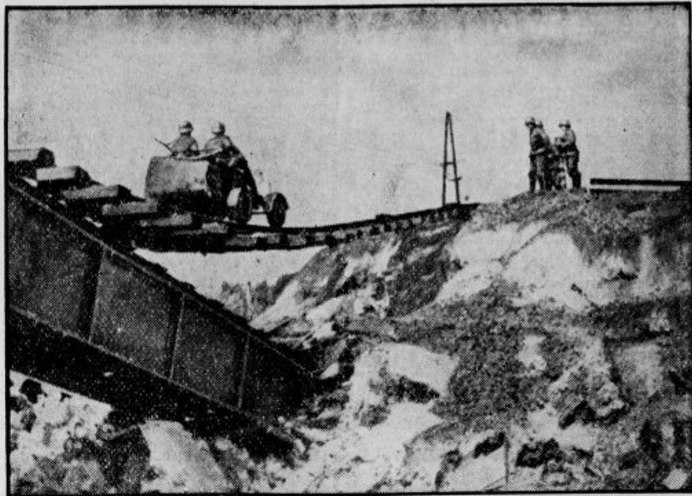
Po takšni, na hitro roko narejeni brvi se prevažajo motorna vozila na bojišča.
