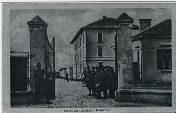
Vhod v Severno vojašnico v Vipavi okoli leta 1928 imenovano Bruner. Dobro se vidi, da obnovitvena dela na strehi niso še končana. Fotografiral Anton Viler.
