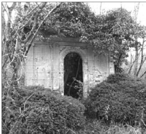
Mikoli s starim vojaškim pokopališčem med prvo svetovno vojno (zgoraj in spodaj); pokopališče danes razpada (levo)
