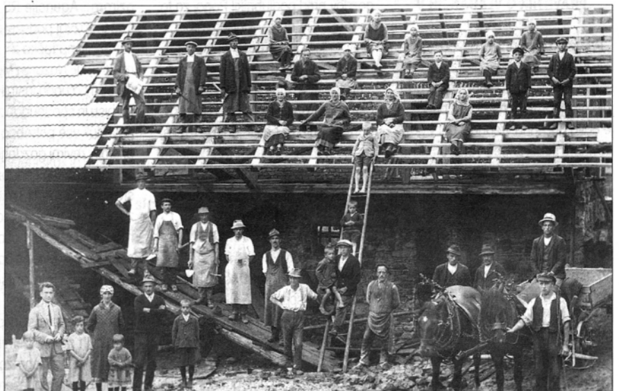
Znano je, da je moziški tesarski mojster Franc Deleja - Žekar izvajal zelo zahtevna tesarska dela v dolini in drugod. Slika je iz časa okoli 1930, ko je na Fužirjevem marofu v Lepi Njivi opravljal obsežna gradbena dela. Na sliki je prvi z leve strani.
