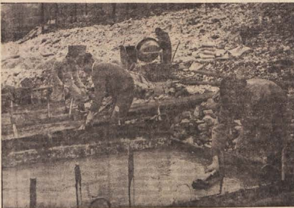
Delavci vodne skupnosti utrjujejo levo obrežje Save med starim mostom in Celulozo. Betonska obrambna steza bo kmalu zabetonirana. — (Foto: Jožica Teppey)
