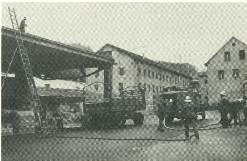
Da se požar ne bo razširil, so na pomoč prišli gasilci iz Žalca. Vodo črpajo iz cisterne.
