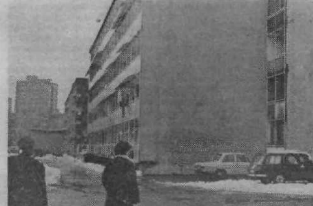
Nadzidave blokov so predvidene v Črtomirovi ulici 22, 23 do 25, 24 ter 27 do 29 in 31; v Neubergerjevi 16, 18 do 20 ter 22 do 24 in v Topniški 60 do 64.
