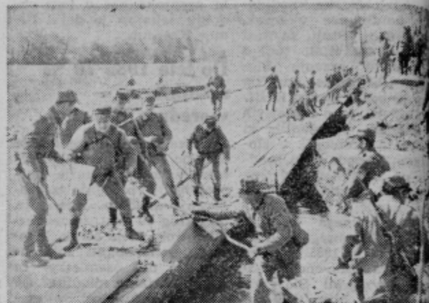
Postavljanje pontonskega mostu čez Kolpo. (F. Legan)
