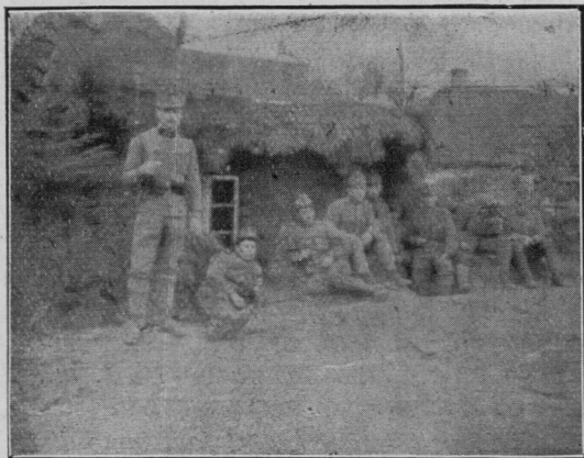
Podzemeljska vila, ki so jo napravili vojaki St Pöltenskega telegraf. oddelka na severnem bojišču. Med njimi (zadnji) Gorenjec B. Walland.
