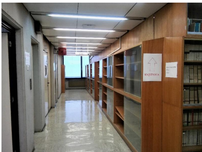
Slika 2: Pogled na hodnik med knjižnico in čitalnico pred prenovi
