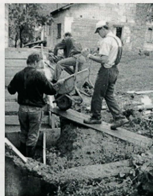
Betoniranje stopnic
