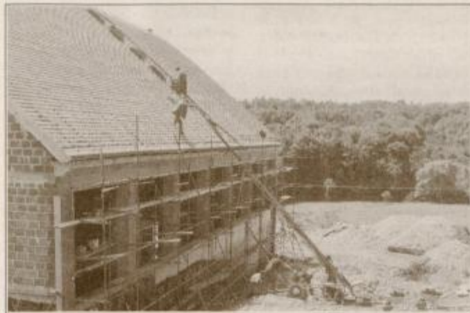
V prejšnjem tednu so pokrili streho telovadnice pri novi završki šoli
