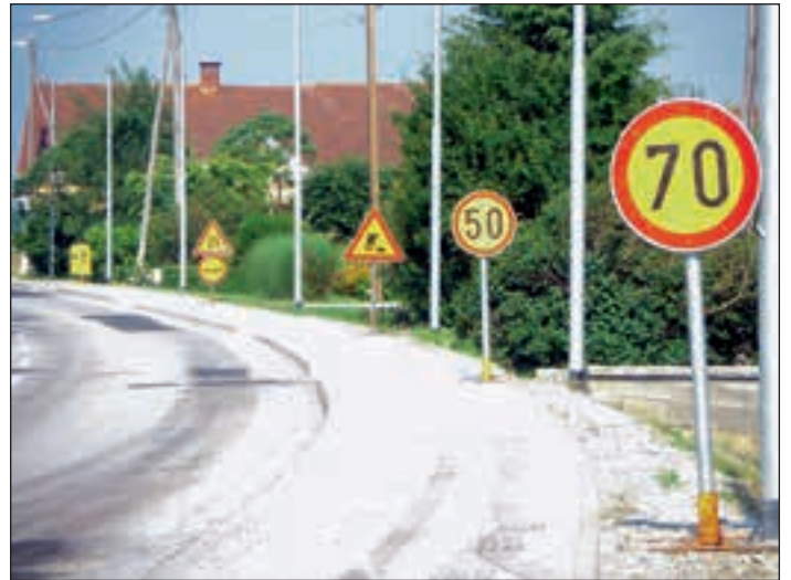
Dela zahtevajo prilagoditev hitrosti vožnje in upoštevanje postavljene signalizacije
