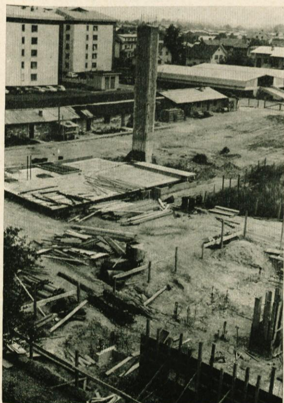
Začetek gradnje 12-nadstropnih stolpnic nasproti Veleblagovnice v Domžalah
